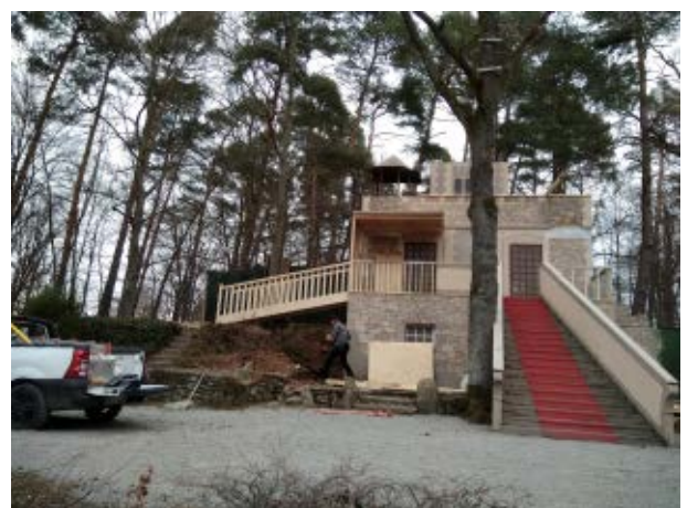
Der Rohbau aus dem Jahr 2018
