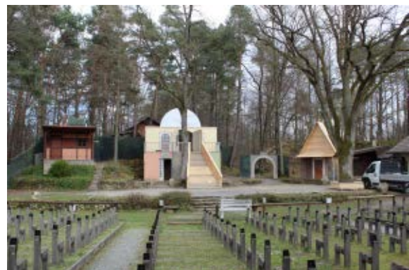
Der Rohbau aus dem Jahr 2018
