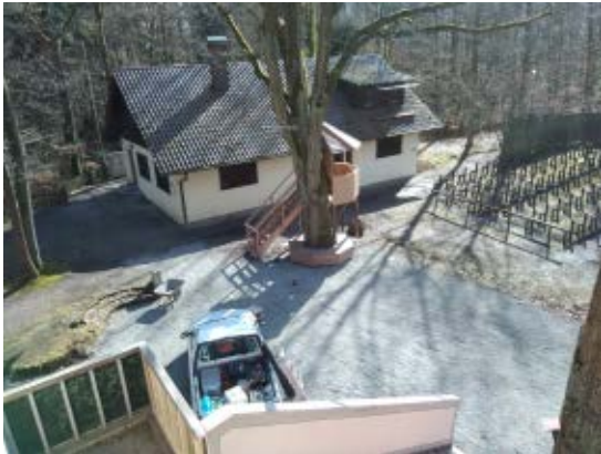
Blick vom Rohbau 2018 aufs Vereinsheim
