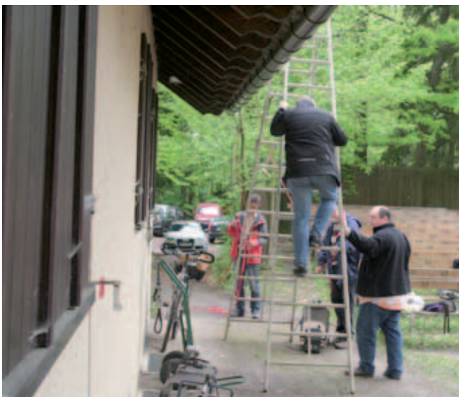
Das Technikteam in vollem Einsatz beim Anbringen der Scheinwerfer (Norbert im roten Anorak)
